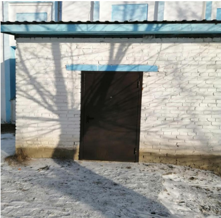
Фото8. Тамбур эвакуационного выхода2.
